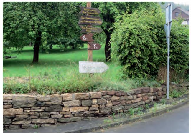
Trockenmauer aus Kalkstein und Buntsandstein, Neuerode
